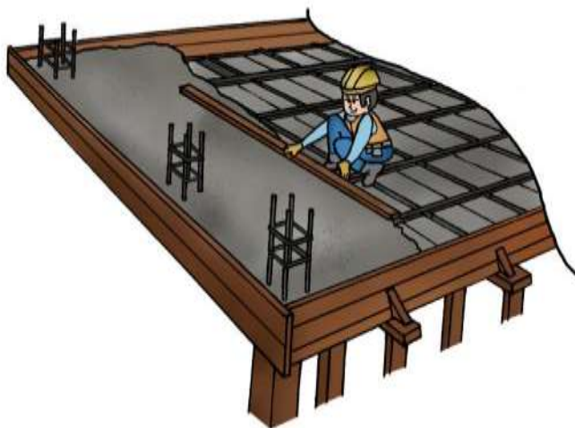
Figura 96: Nivelación de la losa con codal
