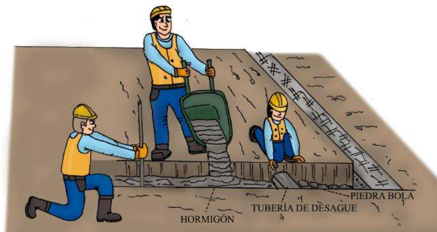
Figura 44: Fundición del cimiento de la cadena.
