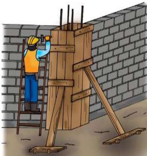
Figura 77: Encofrado de columnas
