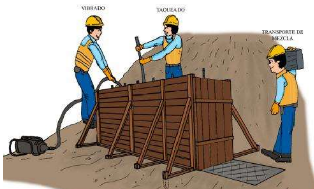
Figura 34: Fundición de muro de contención
