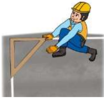
Figura 61: Replanteo de posición de muros sobre cadenas de cimentación y/o sobre losa para construcción de muros
