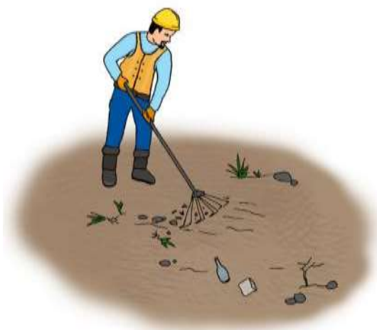
Figura 23: Limpieza del terreno
