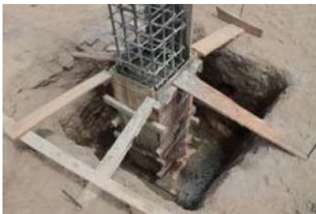
Figura 43: Encofrado y fundido de pie de columna.
