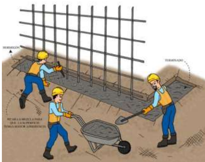
Figura 32: Fundición del pie de muro de contención
