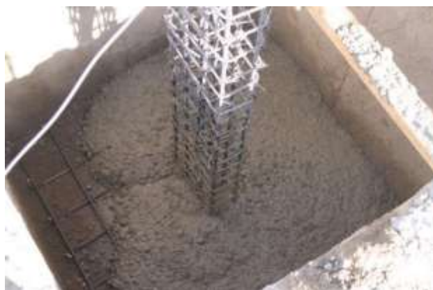
Figura 42: Fundición de plintos.
