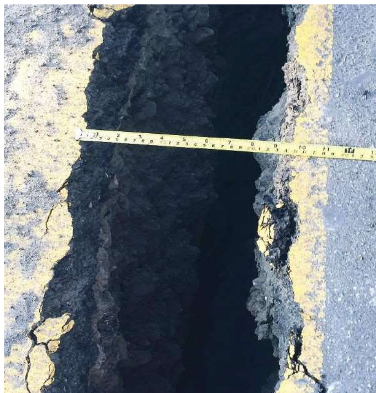
Figura 188: Separación de la calzada por movimiento de suelos. Manabí, Ecuador, 2016
