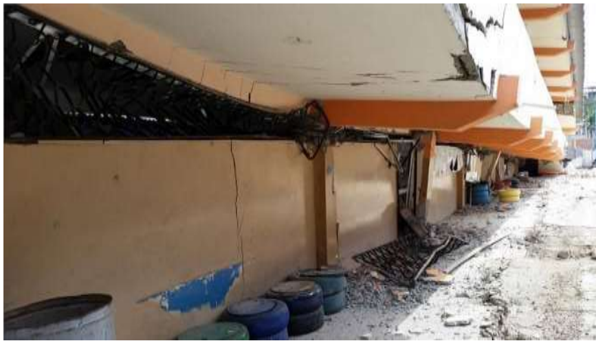
Figura 22: Columnas cortas: Confinamiento lateral de paredes
