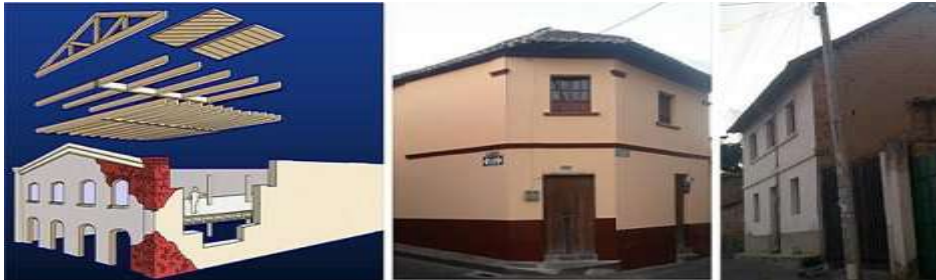
Figura 114: Tipo de sistema estructural: Mampostería sin refuerzo (URM).
