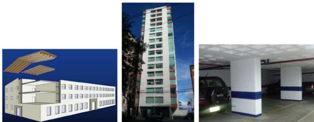
Figura 118: Tipo de sistema estructural: Pórticos de hormigón armado con muros estructurales (C2).
