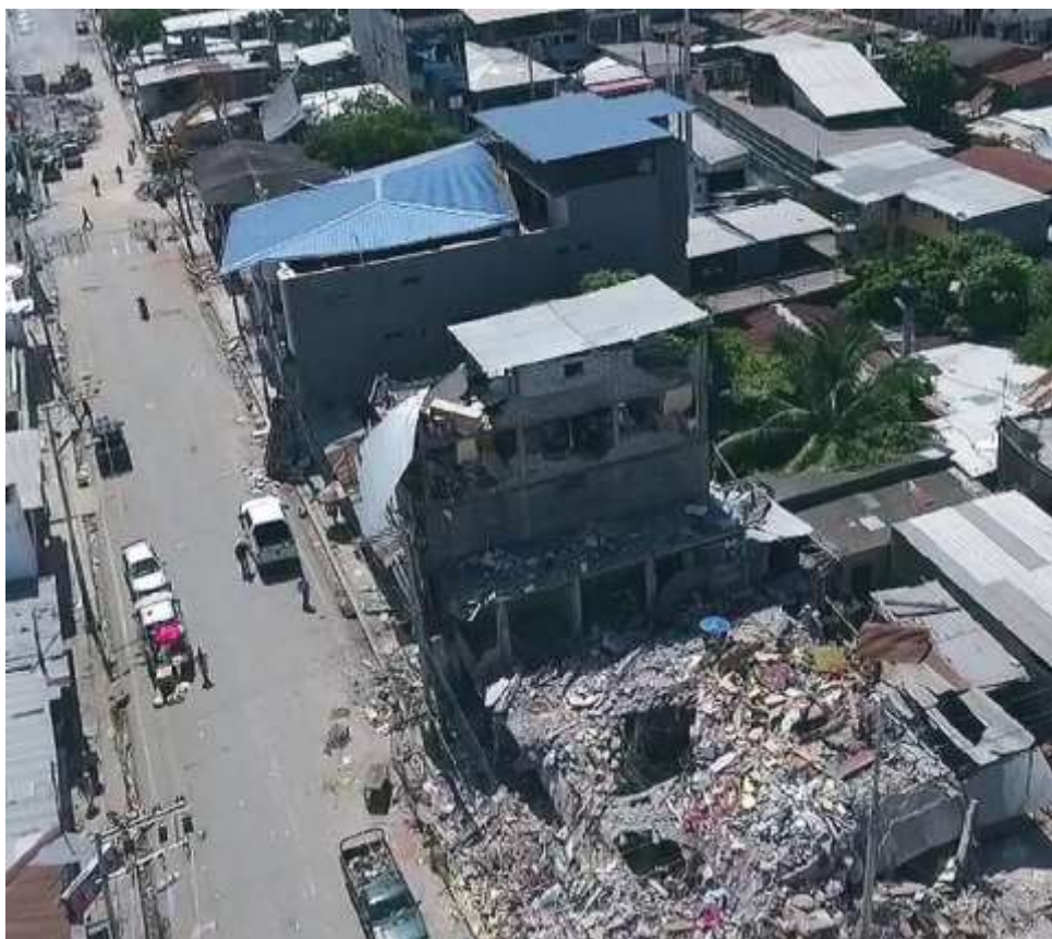
Figura 160: Colapso total de la estructura. Terremoto de Pedernales, Ecuador 2016.
