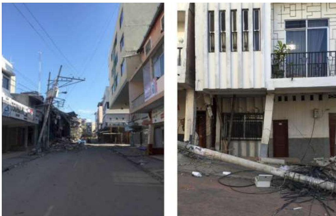
Figura 191: Transformador eléctrico por caer o postes eléctricos en el suelo. Cercar el área insegura.
