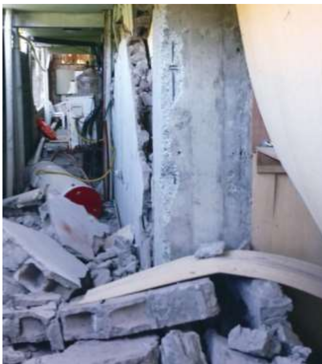
Figura 190: Tanque de propano fuera de su base. Cercar el área insegura. Canoa, Ecuador 2016.
