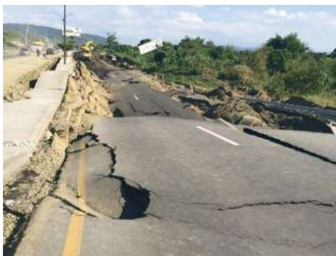
Figura 34: Movimientos laterales y asentamientos excesivos producto de la licuación de los suelos, terremoto Pedernales, Ecuador 2016.
