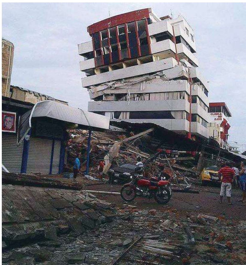
Figura 163: Colapso total de la estructura. Portoviejo, Ecuador 2016.
