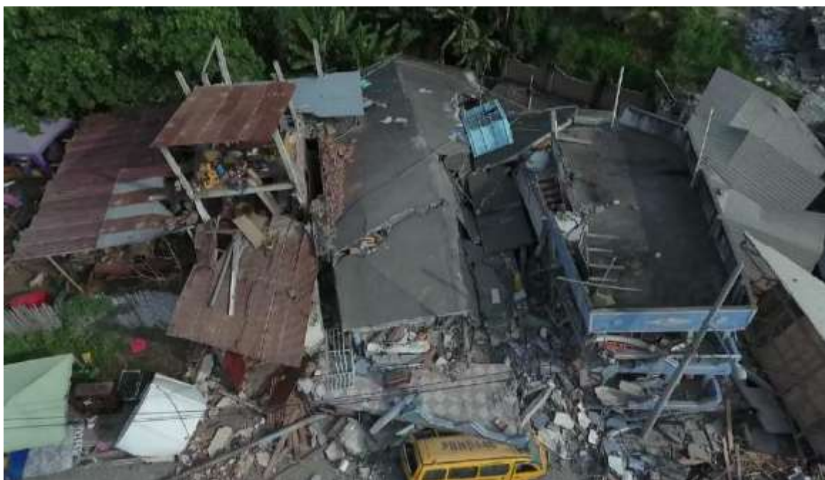
Figura 167: Colapso total de las estructuras. Terremoto de Pedernales, Ecuador 2016. CONDICIÓN 2. La edificación se encuentra fuera de aplomo (Señalizar con pancarta roja: INSEGURA):
