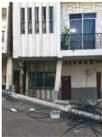
Figura 21: Columnas cortas o esbeltas: terreno con inclinación
