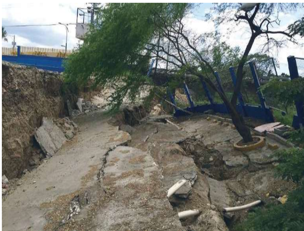
Figura 187: Movimiento considerable del suelo. Manabí, Ecuador, 2016
