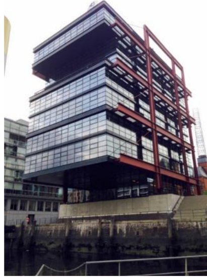
Figura 14. Edificio con pórticos de momento exteriores
